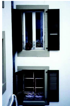
La suppression des subdivisions de la fenêtre ancienne modifie fondamentalement la composition architecturale de la façade.
