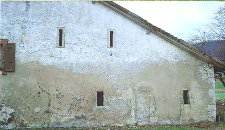
Exemples d'altérations provoquées par l'humidité et les sels.
