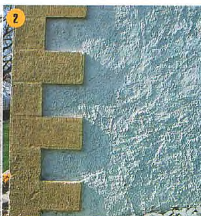
1, 2 et 3. Exemples d'interventions montrant des crépis et des décors anciens conservés sous un badigeon à la chaux ou une peinture minérale.
