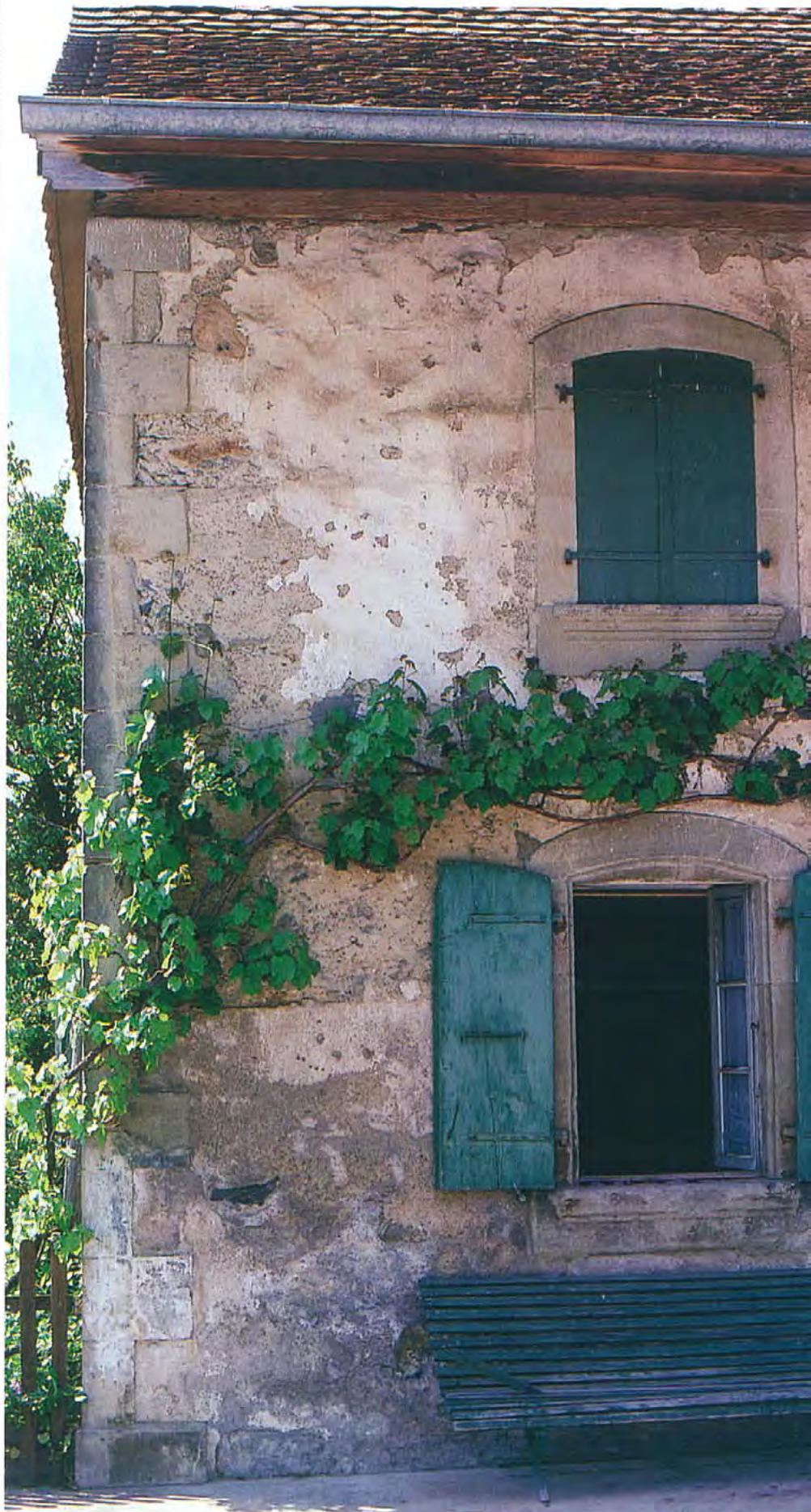
Façade d'une maison villageoise du XVIII e siècle avec de larges plages conservées de son crépi d'origine.
