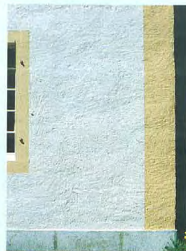
Le crépi raccordé sans surépaisseur permet la réalisation du décor peint.
