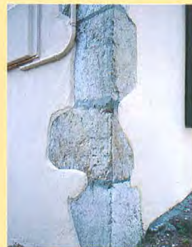
Résultat de ce type d'application avec l'inévitable surépaisseur.
