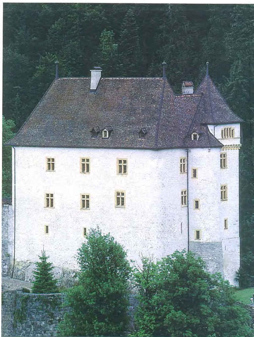
Sur ces façades, le crépi à la chaux datant de 1750 est encore en place.
