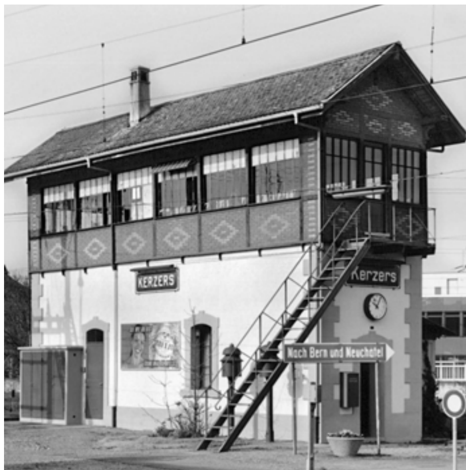
Fig. 1 Recensement Le poste d'aiguillage de Chiètres – Construit en 1896 au croisement des lignes Palézieux-Lyss et Berne-Neuchâtel, ce «monument» de l'industrie ferroviaire est l'un des derniers bâtiments de ce type utilisés en Suisse.
